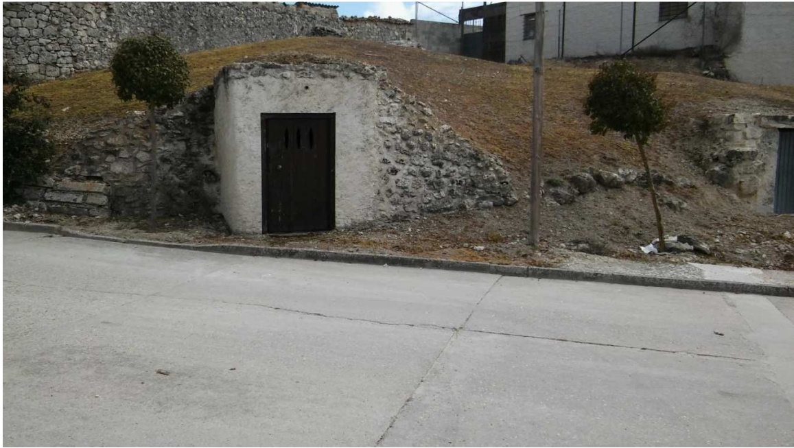
FOTOGRAFÍAS DEL ESTADO ACTUAL DE LAS BODEGAS CON LAS PUERTAS DE ACCESO A LAS MISMAS
